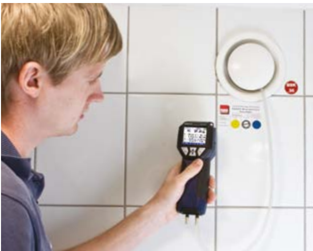
Volumestroommeting bij het inregelen van roosters bij gebruik van de Kv-waarde.
