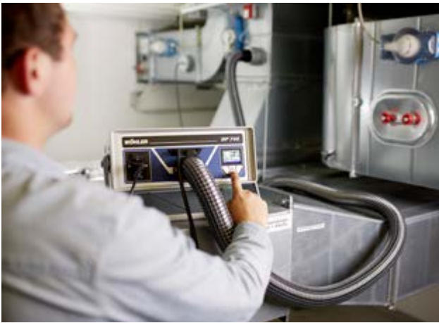
Dichtheidscontrole van geïnstalleerde ventilatiesystemen.
