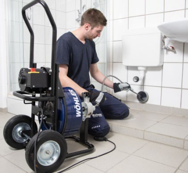
Abb. 7: Während der Rohrreinigung
