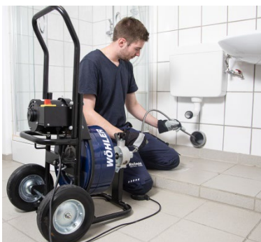
Fig. 32: Nettoyage de tuyaux
